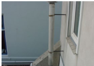
asbestcement hemelwater- afvoer-leiding
