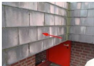
leien tegen de dakrand
