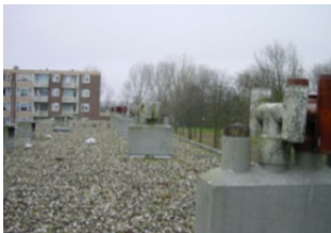
kappen of ontluchting op schoorsteen
