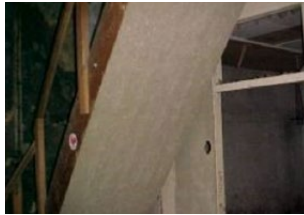
cementplaat op onderzijde trap (brandwerend materiaal)
