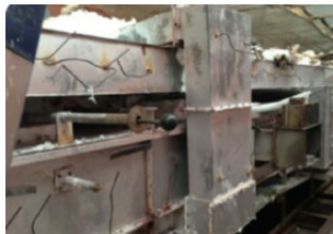
tussen de kanalen is koordpakking toegepast
