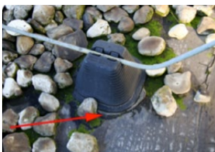
bitumen onder afstand- houder bliksemgeleiding
