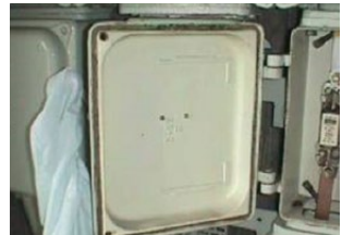
afdichtingskoord in elektrakasten
