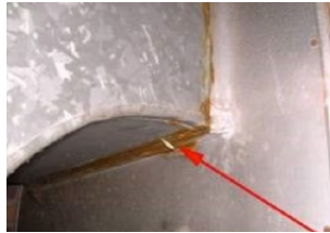
kitafdichting bij metalen lucht- kanaal
