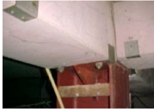
beplating tegen H-balk (staalconstructie)
