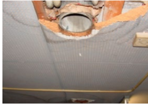
ontluchtingskanalen en ventilatieroosters
