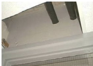
brandcompartimentering (vaak boven verlaagd plafond)
