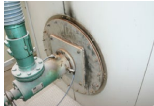
pakking als afdichting brander. Eventueel meerdere pakkingen toegepast
