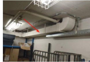
asbestcement luchtkanalen
