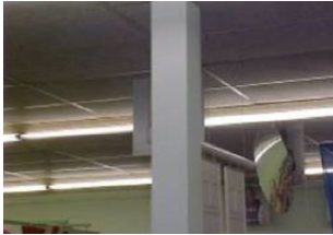
beplating rond kolom
