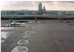
bitumen op plat dak (oude laag)
