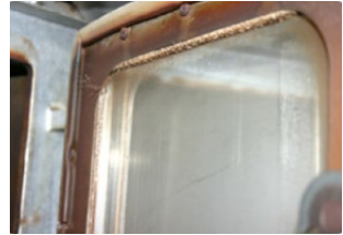
afdichtingskoord, toegepast bij brandwerende luiken, deuren en doorgangen
